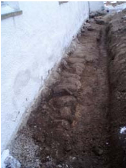
Fig. 9. Dräneringsschakt längs med norra sidan av långhuset.
