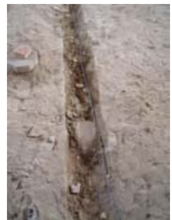
Fig. 4. Befintlig kultvert omgiven av bärlager. Kultverten var ca 0,3 m bred.
