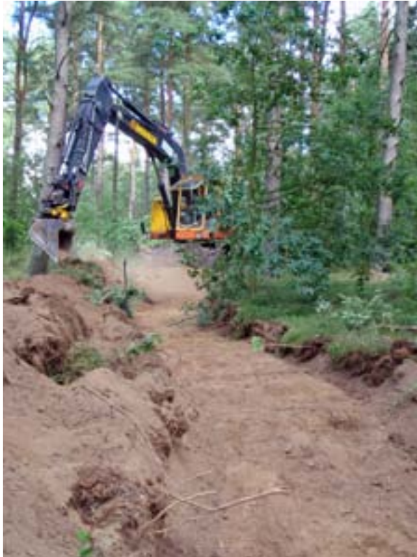
Fig. 8. Schaktning pågår av schakt 11. Notera att det var svårt att identifiera anläggningar i den extremt torra marken.
