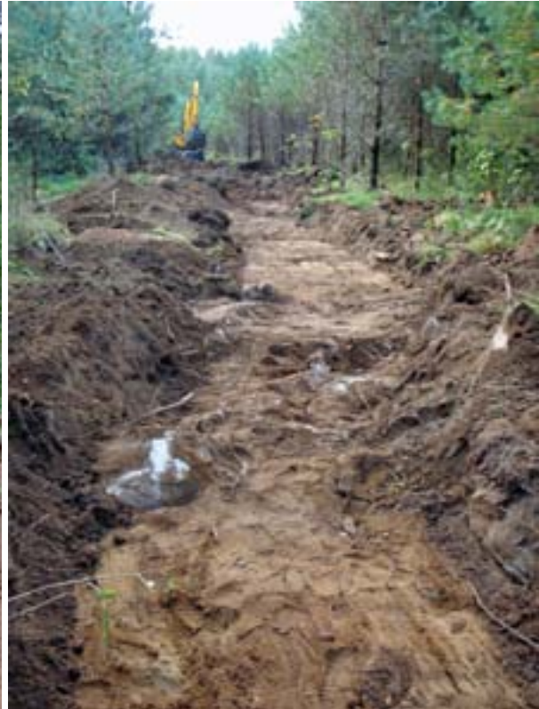
Fig. 9. Schakt 16 med röjningsröset AO 1080 i förgrunden. Foto åt söder.
