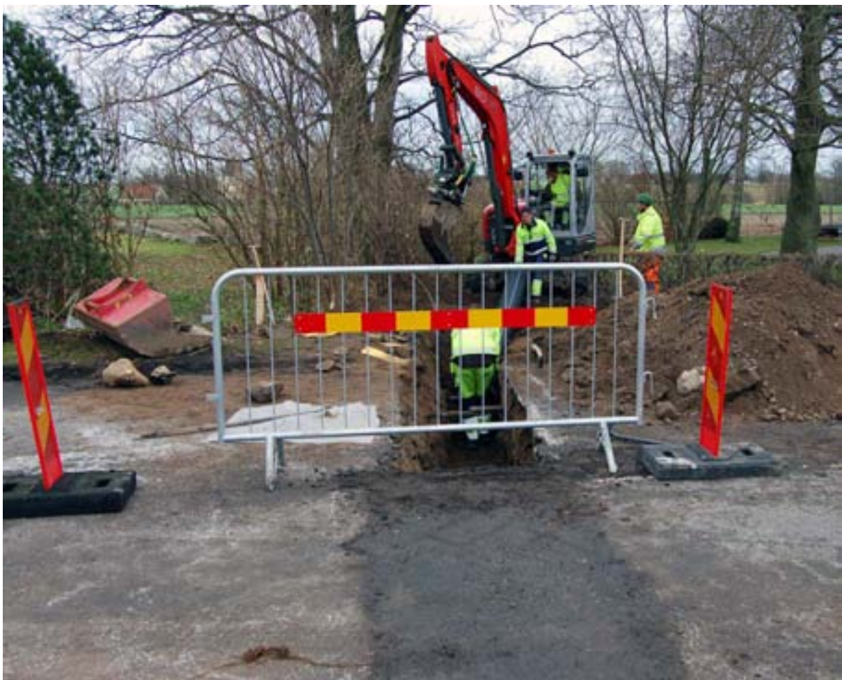
Överst: Utläggning av fjärrvärmeledning söder om riksväg 11. Foto från söder. Foto: Lars Jönsson, Malmö Museer. Nederst: Schaktning genom östra delen av Bygatan och församlingshemmets trädgård..
