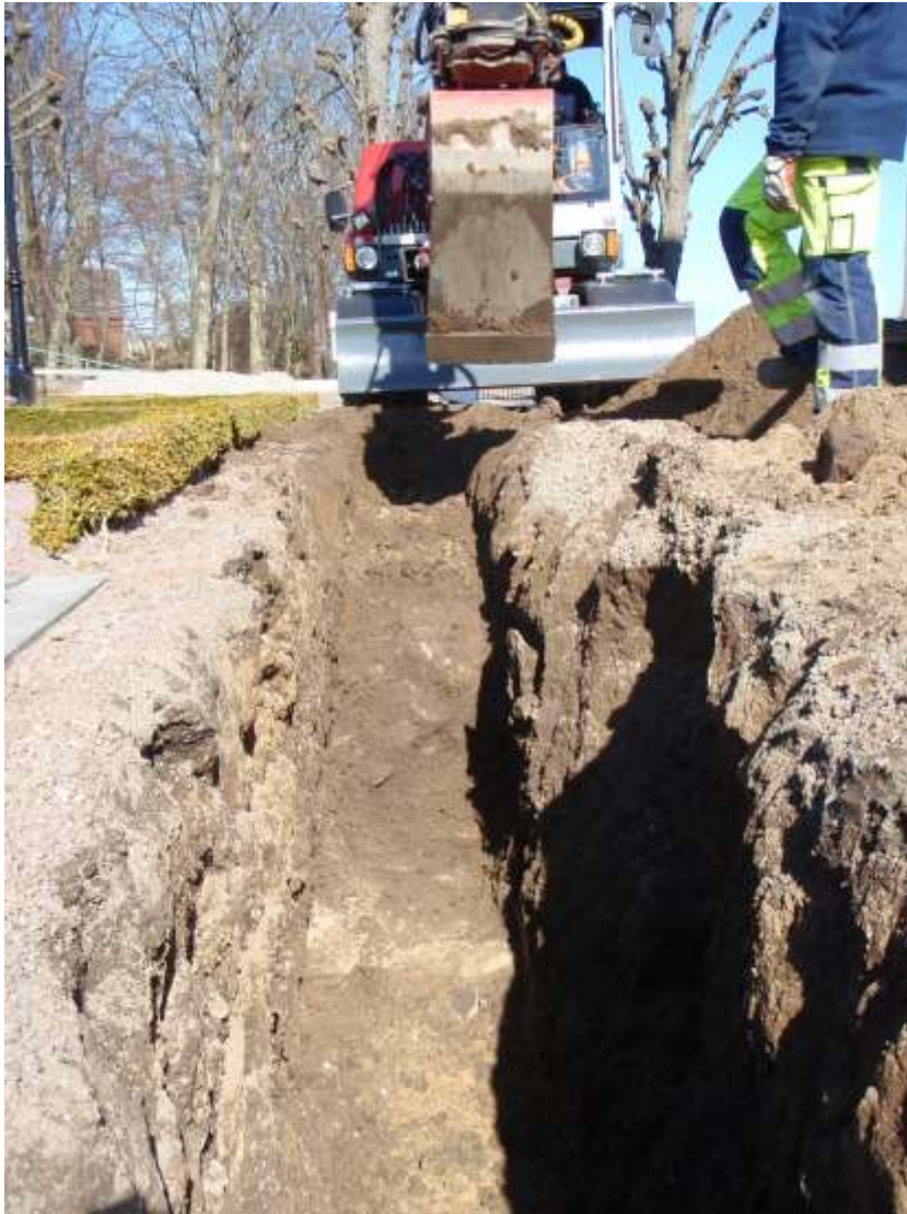
Fig. 4. De flata sandstenschällarna och den södra kallmuren i dräneringsschaktet. Foto åt norr (jmf m bilaga 1).
