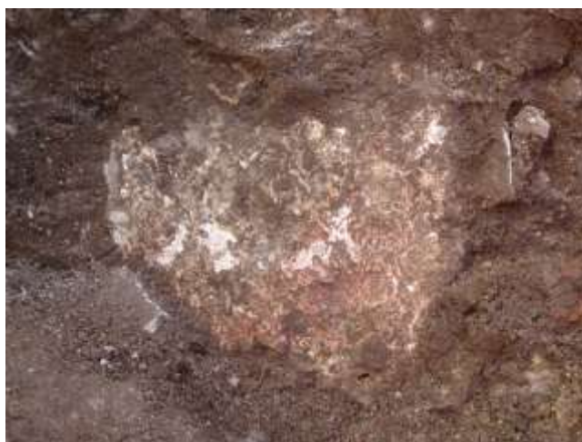
Fig. 3. Den putsade och målade stenen i det nuvarande långhusets grundmur. Foto åt öster.
