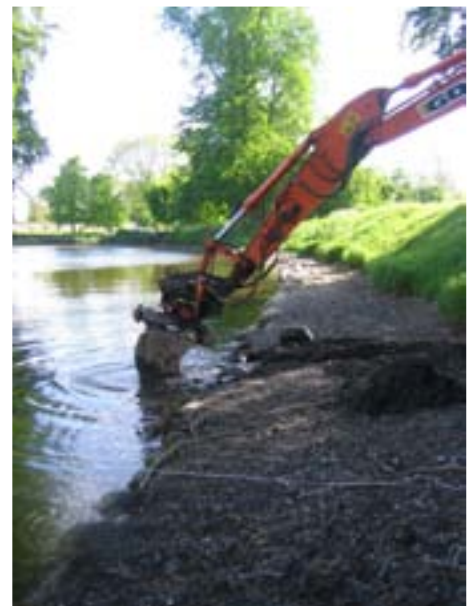
Figur 4. Schaktning genom stenskoningen längs den södra kanten av vallgraven. Foto: Lars Jönsson.
