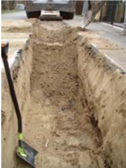
Fig. 3. Schaktet i N. Vallvägen. Naturlig sand och lera.
