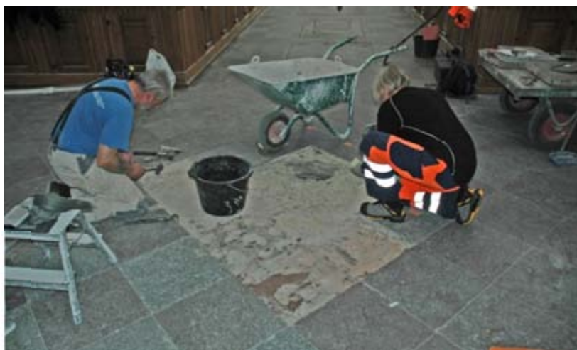
Figur 4. De trasiga golvplattorna i mittgången avlägsnas. Hålrummet under golvplattorna är synligt framför skottkärran.
