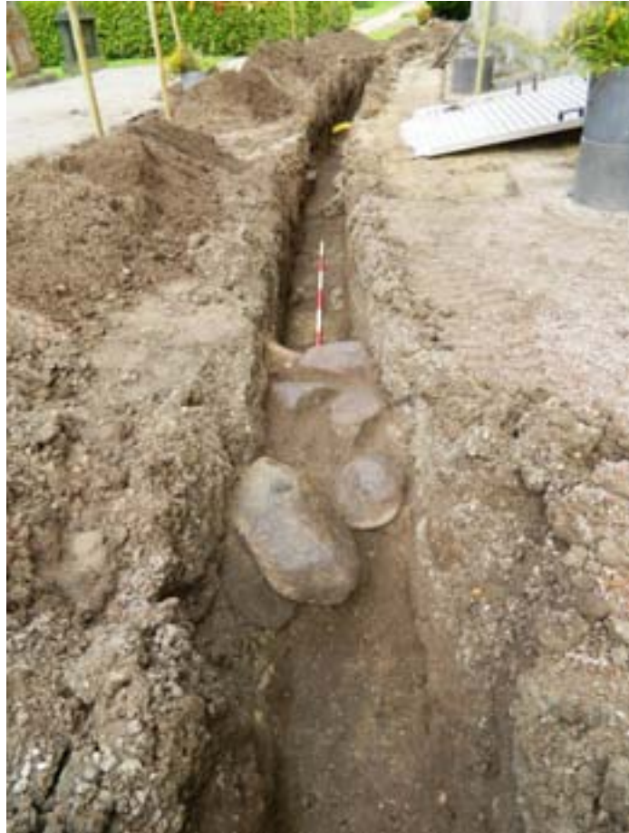
Fig. 3. Schaktet på kyrkans västra sida med de båda stenfundamenten.
