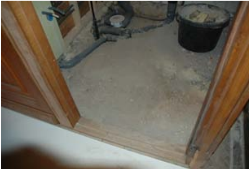
Figur 4. Golvet i toalettutrymmet i tornrummet efter det att klinker och kalkbruk avlägsnats. Foto mot väster.
