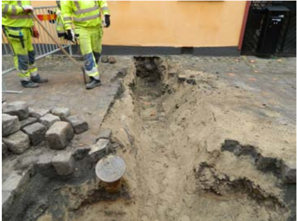
Fig. 3. Förundersökningschaktet från väster. Schaktet visade sig endast innehålla moderna utfyllnadsmassor. Foto Christer Carlsson.
