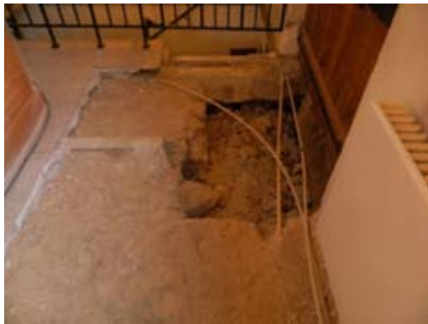
Fig. 4. Schakt för det nya värmesystemet i det norra tvärskeppet. Schaktet visade sig endast innehålla moderna utfyllnadsmassor och inga gravstenar eller äldre byggnadsdetaljer påträffades. Foto Christer Carlsson.
