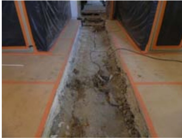
Fig. 3. Schakt för det nya värmesystemet i det södra tvärskeppet. Delar av schaktet visade sig innehålla äldre ledningar, vilka låg i ett betonglager under golvet. Inga gravstenar eller äldre byggnadsdetaljer berördes därför av ingreppen. Foto Christer Carlsson.
