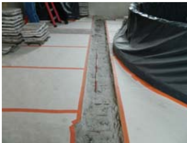
Fig. 5. Schaktet i koret visade sig endast innehålla moderna lager av betong, vilka göts på 1960-talet runt kopparrören i det äldre värmesystemet. Foto Christer Carlsson.
