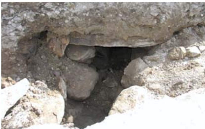
Figur 6. Kulverten vid sektion 20.
