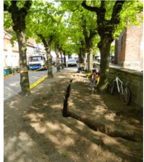
Fig. 3. Schaktet på västra sidan.
