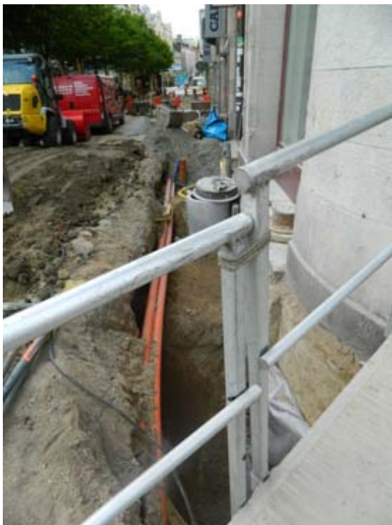
Fig. 5 (t.h.). Schakten runt fastigheten.
