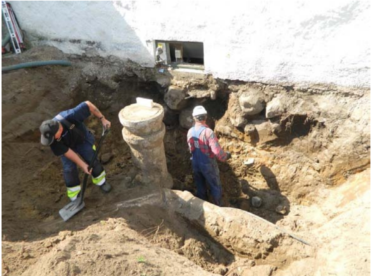
Fig. 3. Mitt i schaktet fanns en VA-brunn och en dagvattenledning. Nykyrkans grundmur bestod av stora stenar lagda utan bruk. Den var omkring 0,9 – 1,0 m djup.
