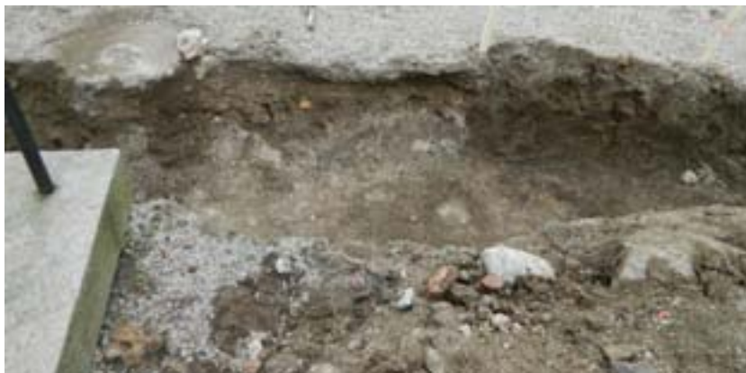
Fig. 5. Kalkbrukslager i den södra rännan på tornets västra sida.
