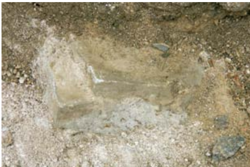
Fig. 7. Bearbetad sten på den norra sidan av tornet.
