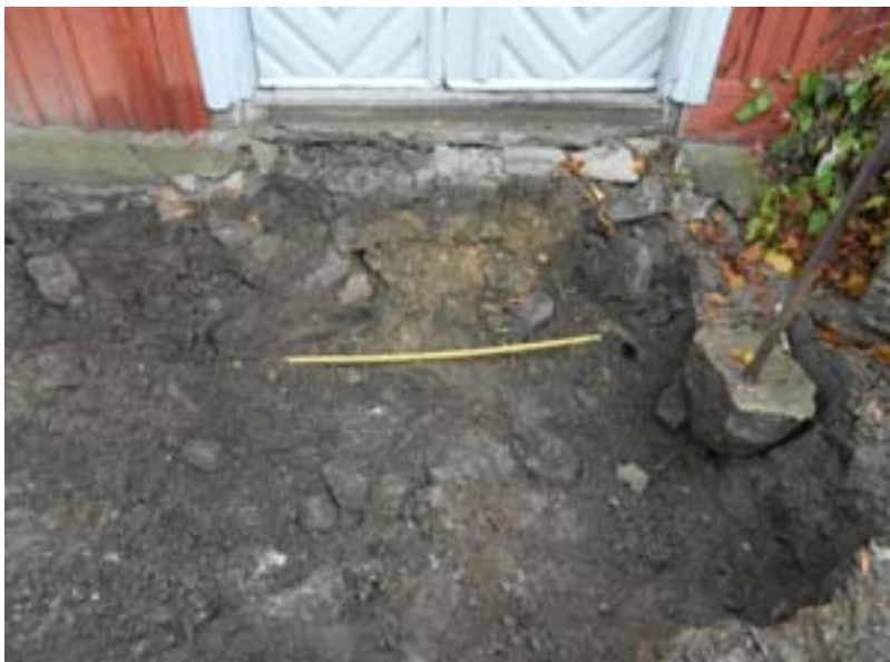
Fig. 5. När den andra stenläggningen tagits bort framkom i schaktets botten ett kraftigt kulturpåverkat lager som också innehöll stenar. Möjligt är detta rester av en tredje stenläggning.
