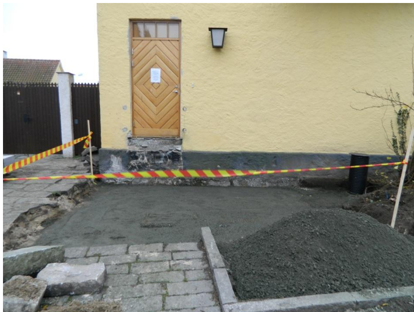
Fig. 4. Schakt 2 hade redan grävts innan arkeolog kom till platsen, och var återfyllt med makadam.
