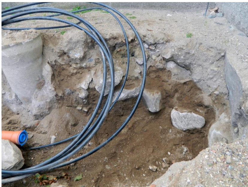
Fig. 5. Stenar i schaktet vid tornets nordöstra hörn.
