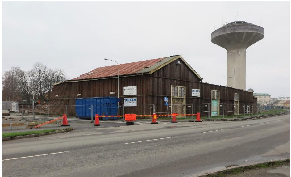
Figur 3. Magasinsbyggnaden under pågående rivningsarbeten i december 2020. Foto: Claes Pettersson, Sydsvensk Arkeologi.
