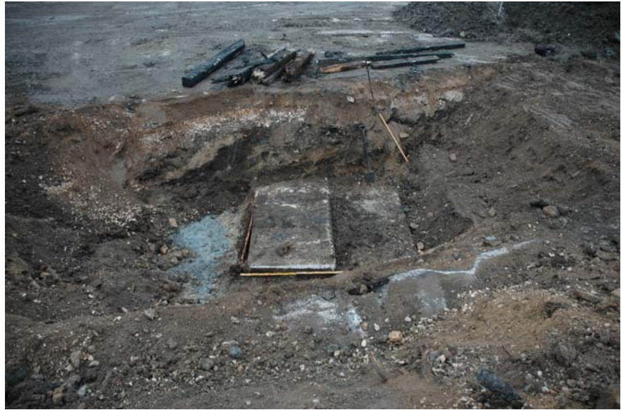
Fig. 6. I schakt 2 framkom rester av äldre hamnkonstruktioner i trä och betong.
