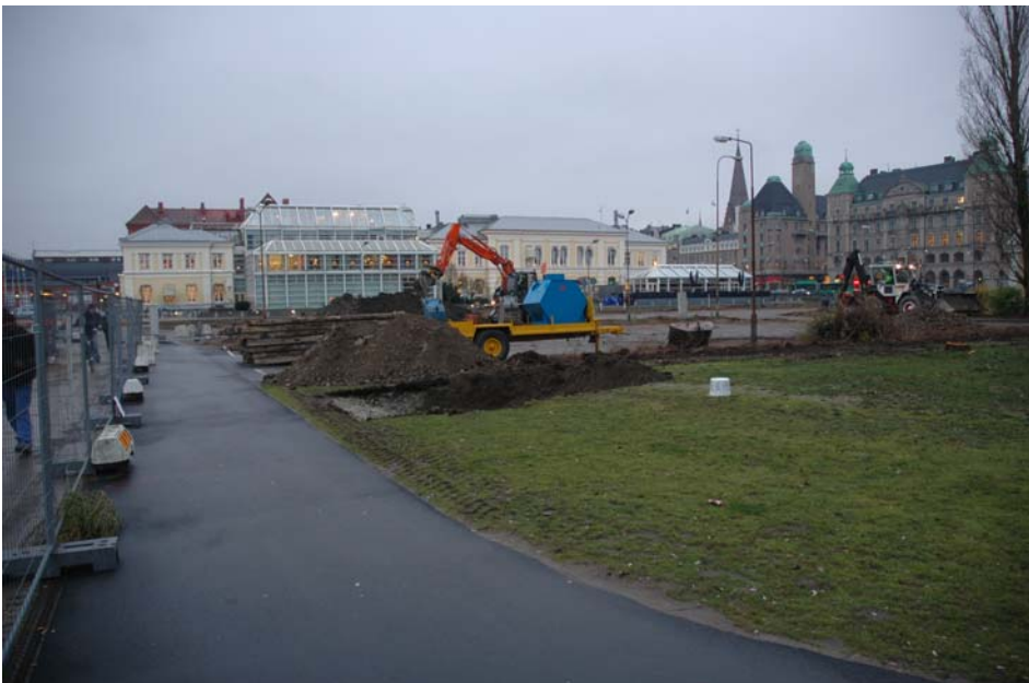
Fig. 4. Schakt 1 sett från nordväst.
