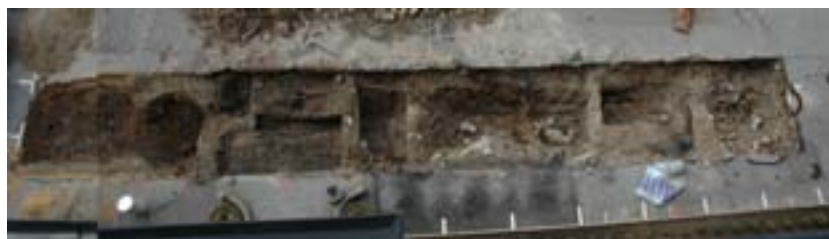
Fig. 13. Schakt 3 från Ö.
