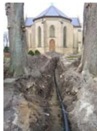
Foto 5: Schakt ut mot bogårdsmuren.
