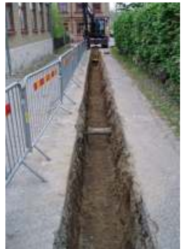
Fig. 16. Södra delen av schaktet i Färgerigatan. Foto åt söder, Jan Kockum.
