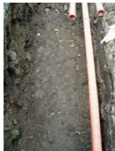
Fig. 14. Äldre gatubeläggning i Companiegatan. Foto åt väster, Jan Kockum.
