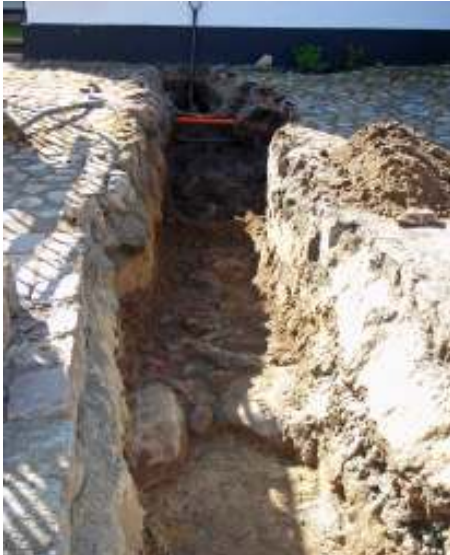
Fig. 15a. Syllstensgrund och stenläggning i servisschaktet till kv Möbelsnickaren 2. Foto åt syd, Tony Björk.
