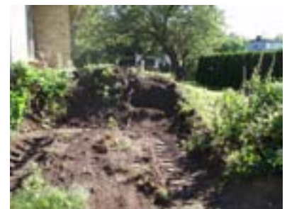
Fig. 5. Schakt 2, bortgrävning av kullen framför trädgårdsdörren.
