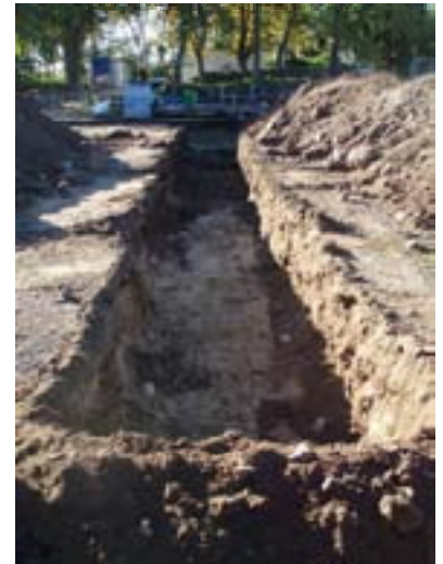
Foto 3: Schakt 3 från norr. I Bakgrunden syns betongplattan som skar gravarna 1 och 2 vilka undersöktes under besiktningen (se ovan).
