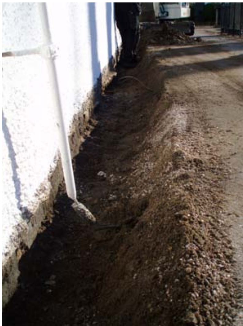
Fig. 4. Schaktet längs med kyrkans södra sida. Foto från väst.
