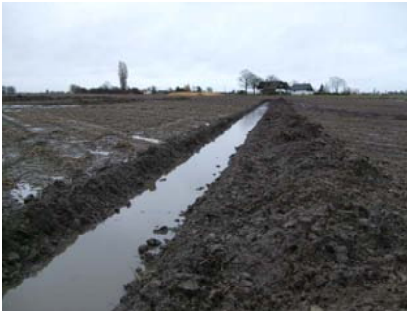
Figur 5. Vattenfyllt schakt i norra delen av UO den 23/11 2010. Foto: Elisabeth Rudebeck.
