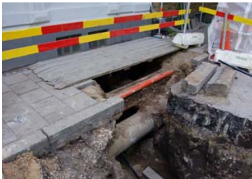
Figur 3: Foto som visar en del av de ledningar som framkom i det schakt som öppnades för att lägga fjärrvärmeledningen.
