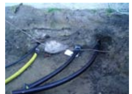
Fig. 6. Schakt för genomföring i kyrkans grund.
