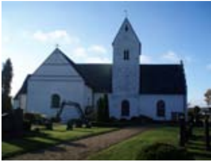
Fig. 3. Köpings kyrka vid schaktningen inom kyrkogården.
