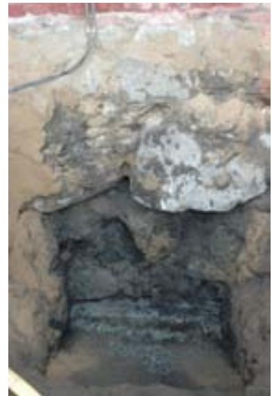
Figur 6. Schakt 3 vid huvudbyggnaden inne på borggården. Det fanns fem skikt med grundstenar. Grunden vilade på kompakt sand.
