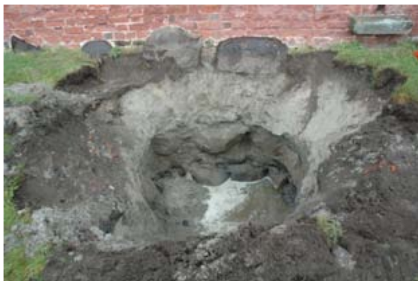
Figur 5. Schakt 2 väster om huvudbyggnaden. I schaktet fanns fyra skikt med grundstenar. Tyvärr vattenfylldes den nedre delen av schaktet relativt omgående. Foto: Lars Jönsson.
