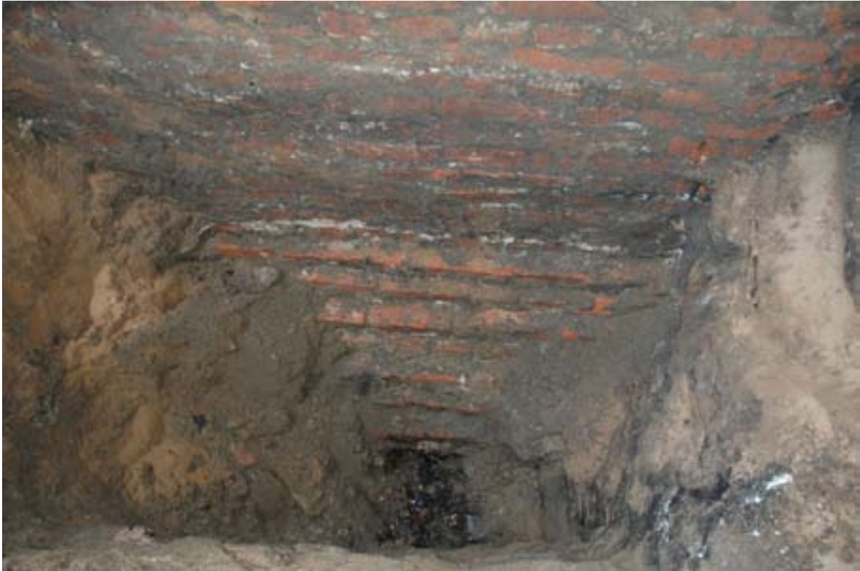
Figur 8. Kompletteringsschakt vid strävpelare. Grundläggningen utgjordes överst av en ca 1,2 m hög tegelmur. Under tegelmuren fanns en grund med tegelstenar i sju avsatser. Foto: Lars Jönsson.
