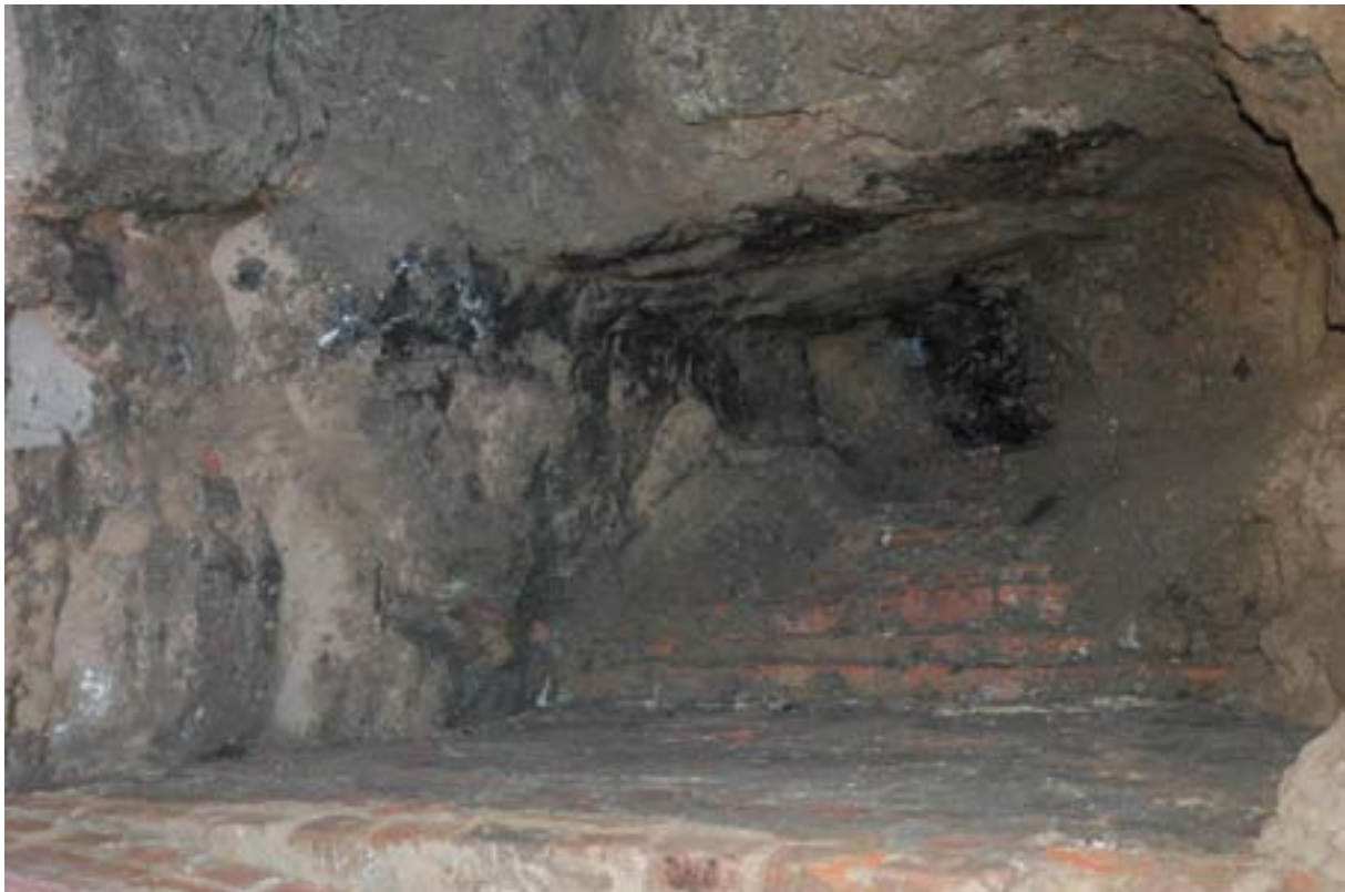
Figur 9. Kompletteringschakt vid strävpelare. Grundläggning av tegel till ett djup av ca två meter. Foto: Lars Jönsson.
