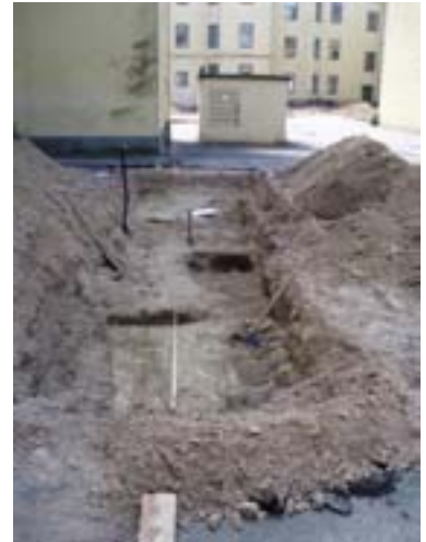
Fig. 5. Schakt 5 från öst.
