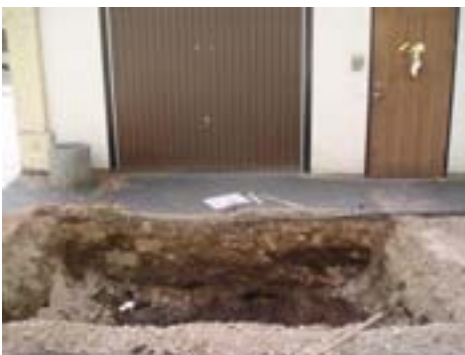
Fig. 4. Schakt 1 från öst.
