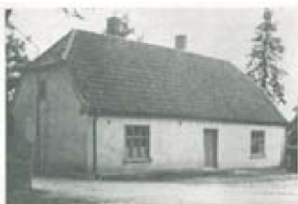
Figur 4. Kantorshuset i Skurup. Foto: G. Trotzig.
