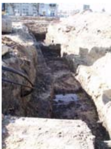
Fig. 5. Schakt 1 från Ö.
