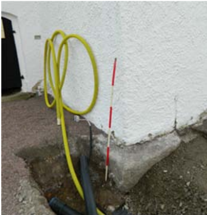
Fig. 3. Schaktet längs tornets nordsida drogs fram till en befintlig dagvattenbrunn invid kyrkans fundament.
