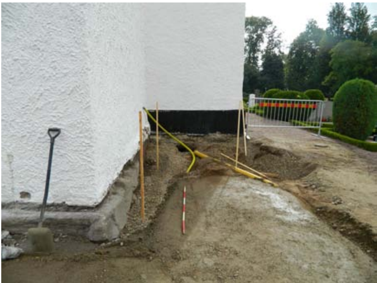
Fig. 4. Schaktet längs tornets sydsida låg alldeles intill tornets kraftiga gråstensfundament.
