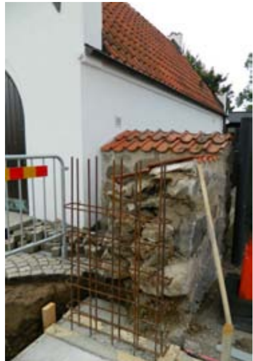
Fig. 5. Genombrytningen av kyrkogårdsmuren vid Bårslövs kyrka. Foto visar murens uppbyggnad och dess kärna av gråsten och murbruk.
