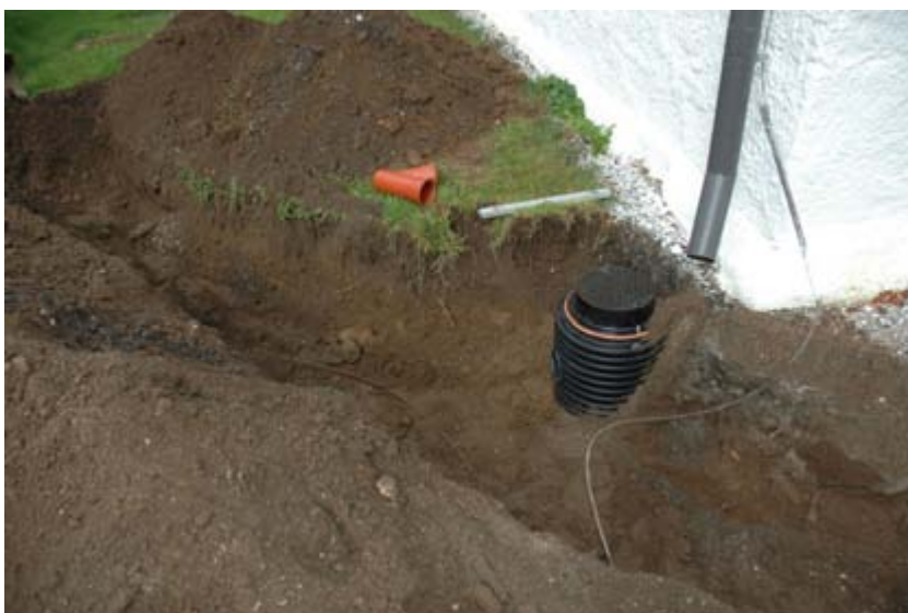
Figur 8. I schaktet för dagvattenledningen på korets södra sida fanns ett stratifierat lager med gråbrun humös silt.
