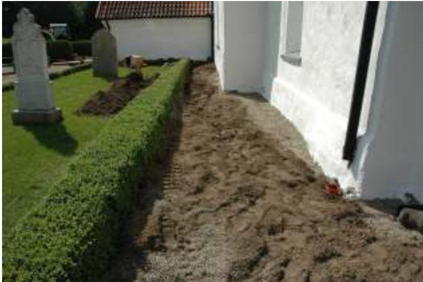
Fig. 4. Schaktet på södra sidan (från Ö).
