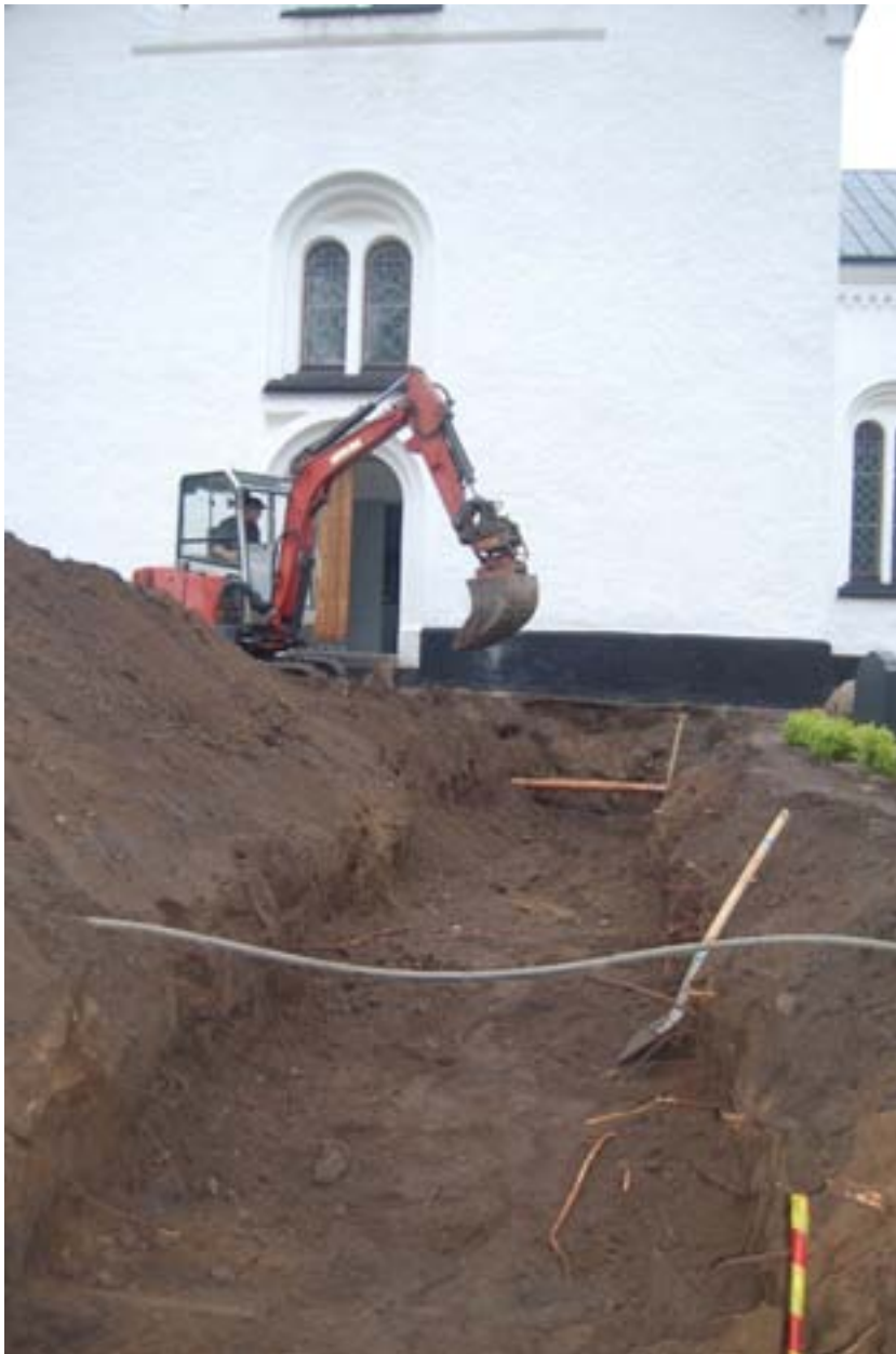
Figur 4. Schaktet upp mot kyrkan. I botten på schaktet kunde minst tre nedgrävningar för gravar ses.
