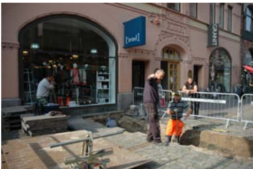
Figur 3. Schakt 1 löpte ca 12 m i östvästlig riktning tvärs över Södergatan. Foto mot norr.
