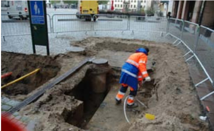
Figur 5. Fjärrvärmekulvertar i schakt 2, utanför Södergatan 10. Foto mot norr.
