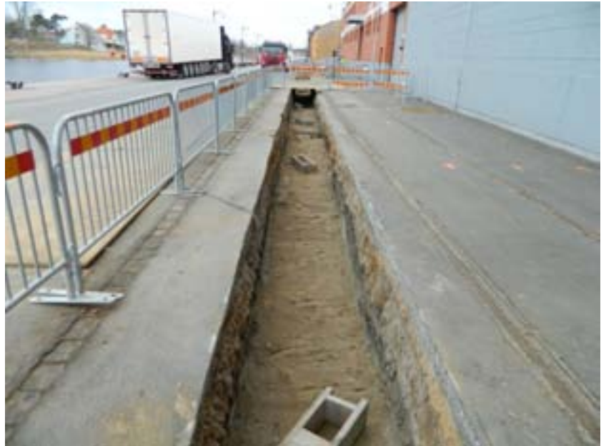
Fig. 3. Det gråaktiga lerlagret syns på bilden i profilväggen av fjärrvärmeschaktet nere vid Gamla Skeppsbron. Lagret hade avsatts i kanten av Helgeå genom äldre tiders aktiviteter på platsen. Foto av författaren från öster.
