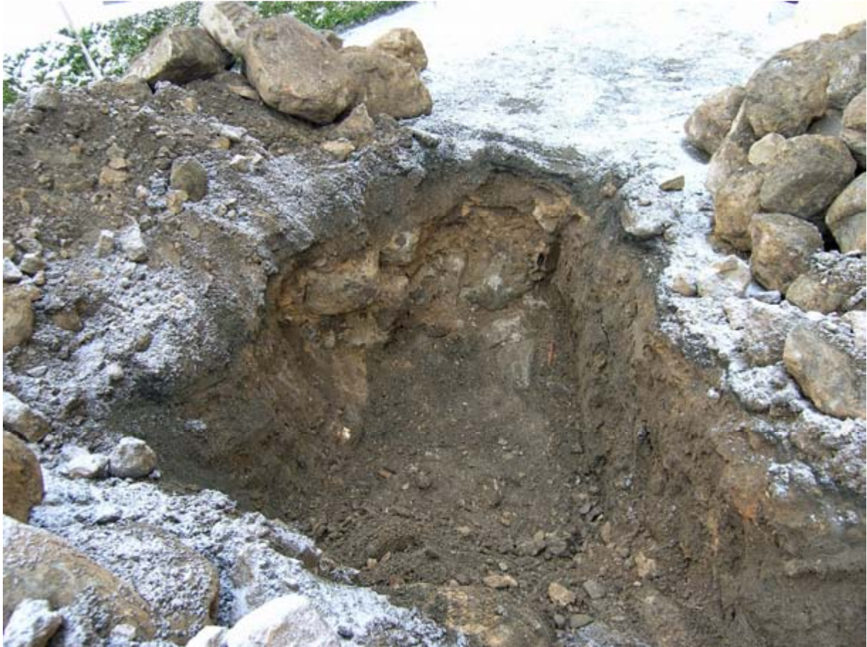
Fig. 3. Större delen av en äldre mur hade hunnit tas bort innan den hann dokumenteras. Bilden visar undersökningschaktet efter upprensning. Murens konstruktion består av större stenar lagda i kalkbruk. Foto: Lars Salminen.
