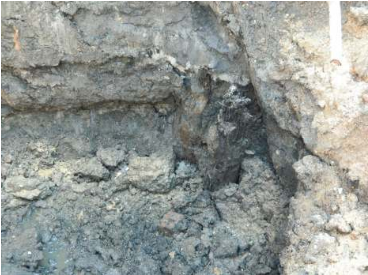
Fig. 3. Pålning i det norra kabelschaktet i korsningen Östra Boulevarden/ Norra Boulevarden.
