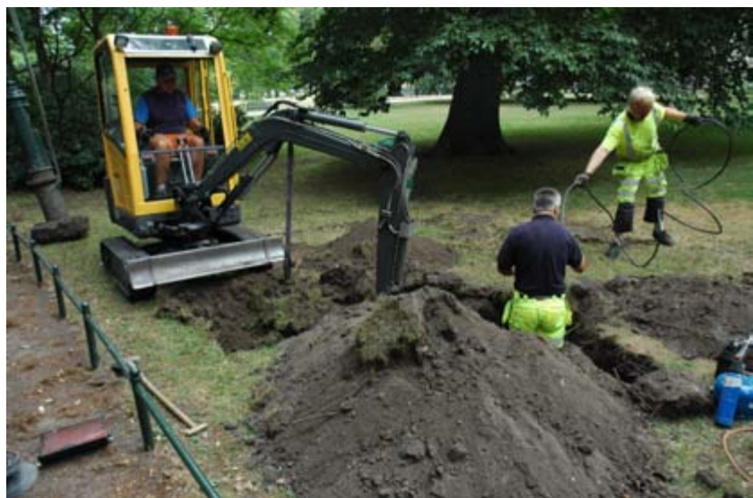
Figur 5. Den gamla lyktstolpen har lyfts upp vid schakt 5 och står bakom grävmaskinen. Hålet för lyktstolpens nya placering grävs.
