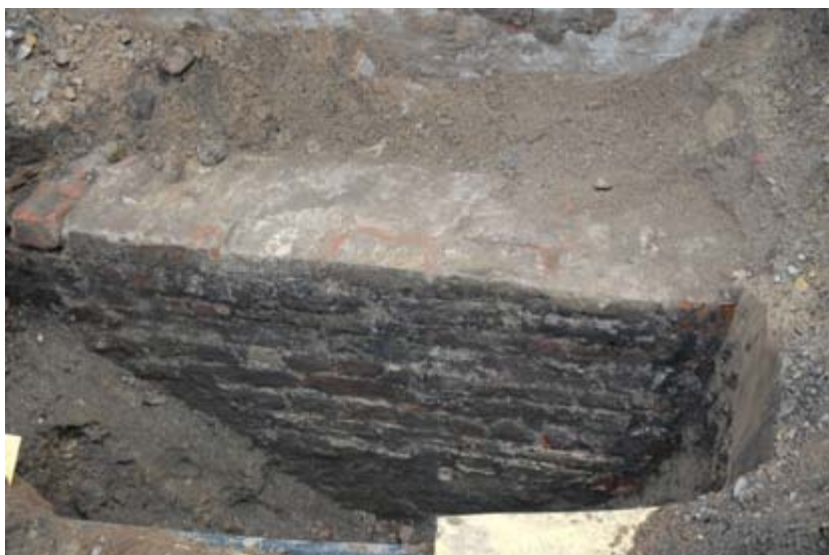
Figur 6. Muren i schakt 6.
