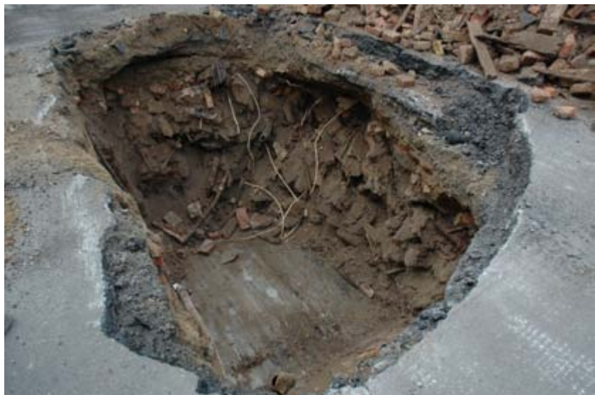
Figur 8. Schakt 11 med raseringsmassorna synliga.
