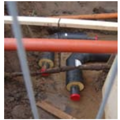
Figur 3: Ledningarna drogs i ett äldre ledningsschakt
